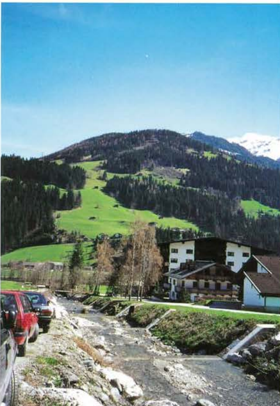
タールバッハの溪流対策工事現場。ここでは工事中は既存建物ぎりぎりまで危険区域をかけるが、完了後は管理幅員（兩岸3m位）まで縮小すると、ザウアーモーザー氏の説明。
