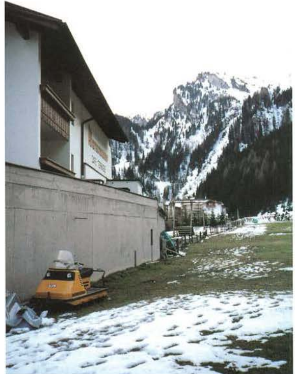
雪崩の来る斜面側に建物を保護するための塀を作った。ヒントートゥックスのスキー宿で。
