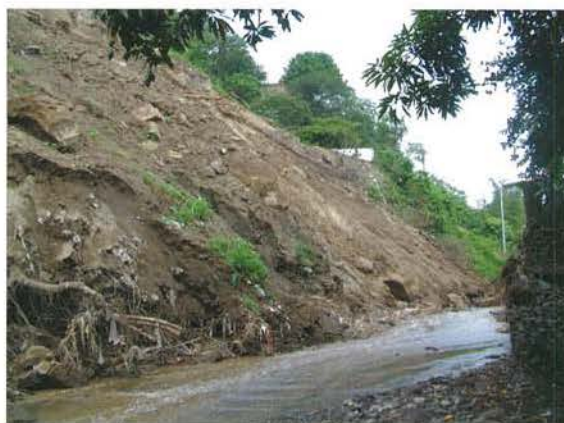
写真-7 集落内河岸崩壊。斜面中腹の住宅が崩壊で消失。
