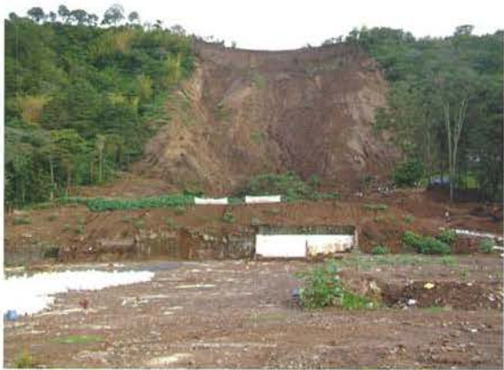
写真-3 6月のラス・コリナスの崩壊跡。
