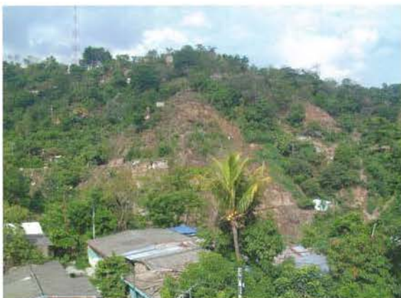
崩壊により斜面中腹の住宅が消失。
