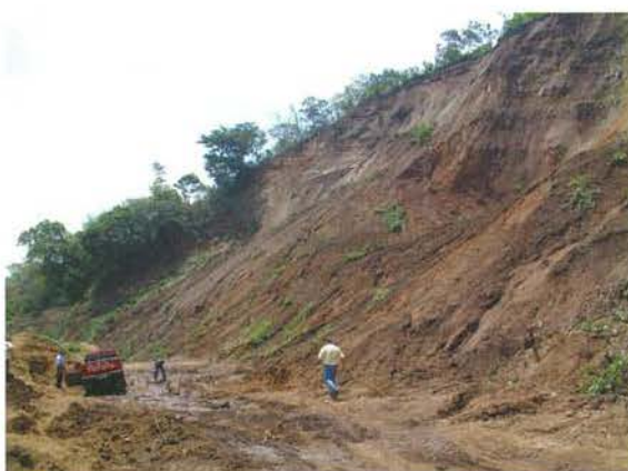
道路を埋めた崩壊土砂が雨で泥水となり四輪駆動も通行が困難。コマサグア道路。
