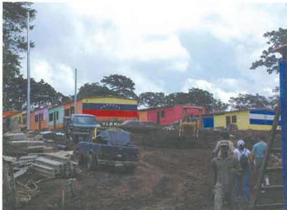
写真-10 ベネズエラ軍による被災者用住宅建設。42m 2 で浄化槽付き。
