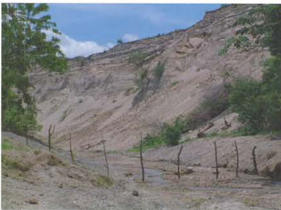
写真-8 地震で起こった河岸崩壊。
