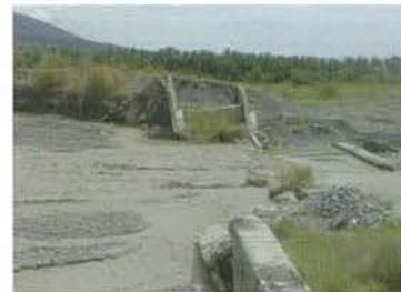
写真-10 スラウェシ島レワラ川床固工破損状況→コンクリートの低品質が原因
