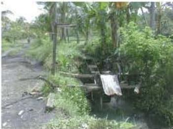
写真-3 用水路に設置した発電器
