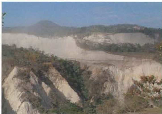
写真-19 2月13日の地震でこの付近は、のきなみ沿岸崩壊が発生 (2月17日)
