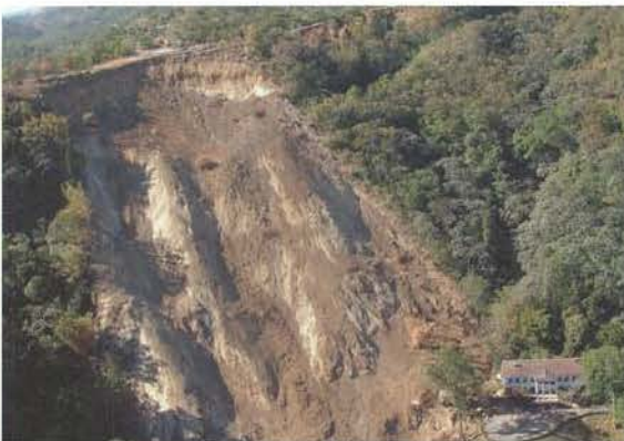
写真-11 崩壊上部 (2月14日)
