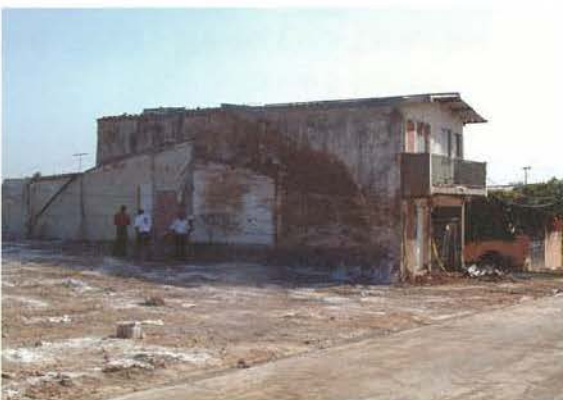
写真-12 崩壊土砂が家屋に飛び散った跡 (2月15日)
