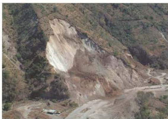
写真-8 1月13日の地震による崩壊 (2月14日)
