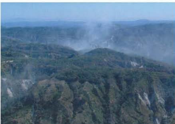
写真-5 2月13日の地震による崩壊箇所からあがる白い土砂煙 (2月14日)
