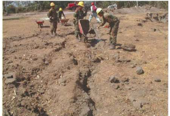
写真-13 崩壊上部の尾根の亀裂をモルタルで埋めているところ (2月16日)
