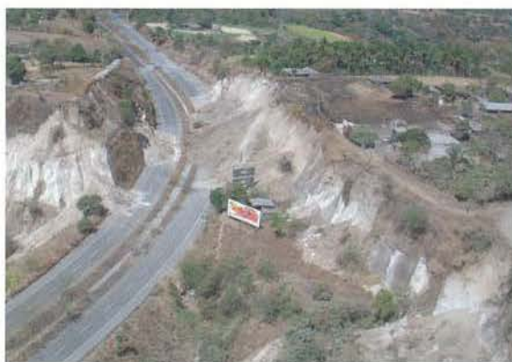
写真-9 2月13日の地震による崩壊 (2月14日)
