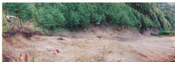
写真-2 日野町榎市での崩壊状況（鳥取県土木部河川砂防課提供）
