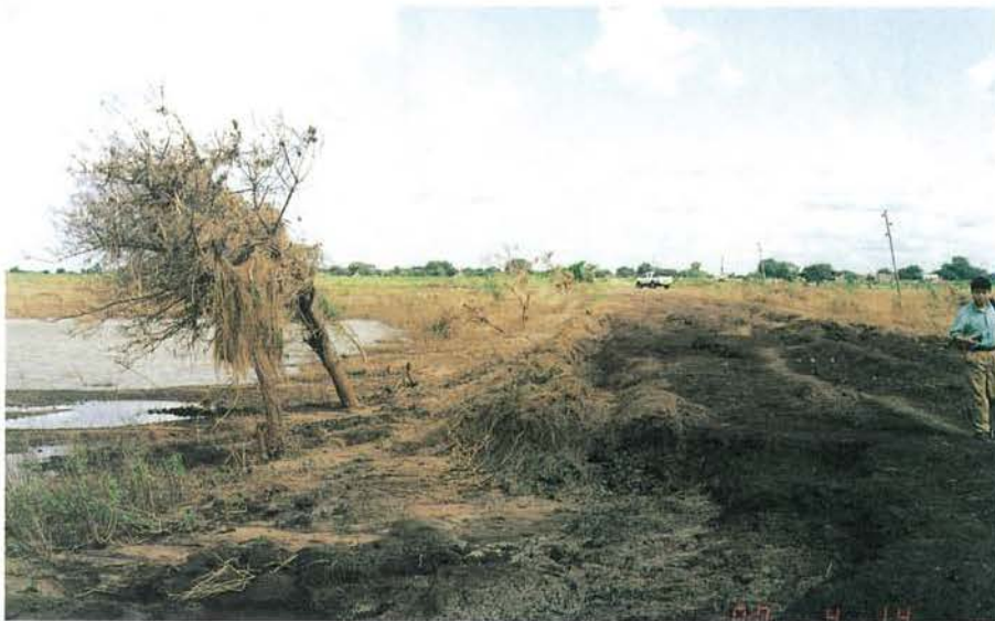
溶けて無くなった道路、左側にある樹木の枝に枯草がひっかかっている
