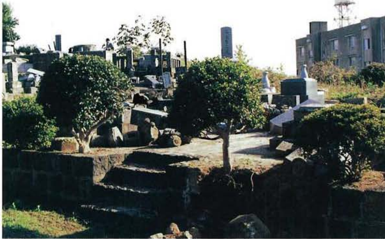
米子市青木地区における墓石の転倒状況
