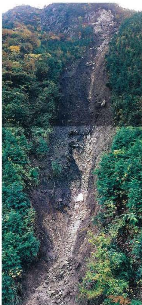
日野町道三原上流における斜面崩壊状況
