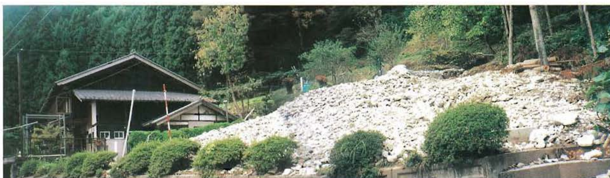
写真-2 土石流堆積状況（奥犬間沢）
