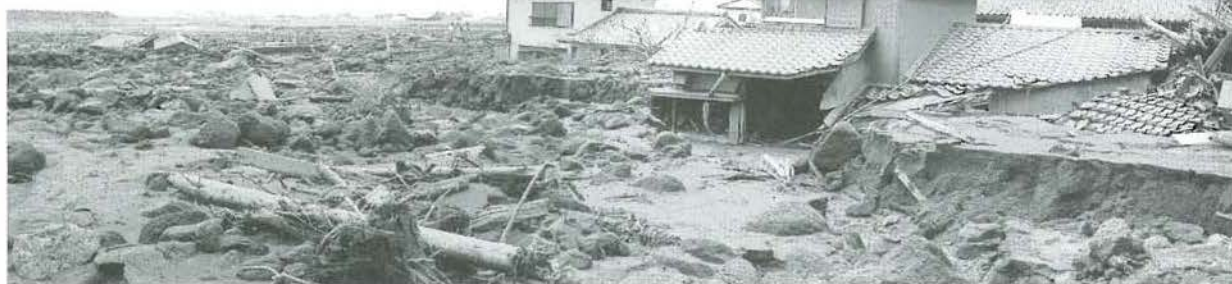
最大規模の土石流に襲われた安中三角地帯（1993.6.20撮影）
