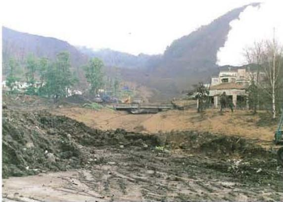
写真-2 西山川流路工を埋塞した熱泥流堆積物(7月12日、安養寺撮影)
