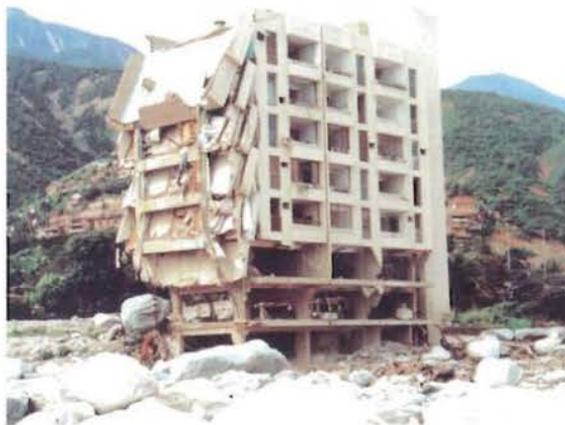
写真-3 サン・フリアン渓流の土石流により被災したコンクリートの建物
