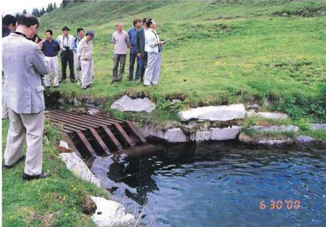
写真-3 導水管流入部
