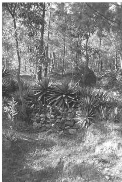
写真-1 ジクコーラ (川) のガリー浸食防止のための空石積み谷止工 (周囲は森林が回復している)
