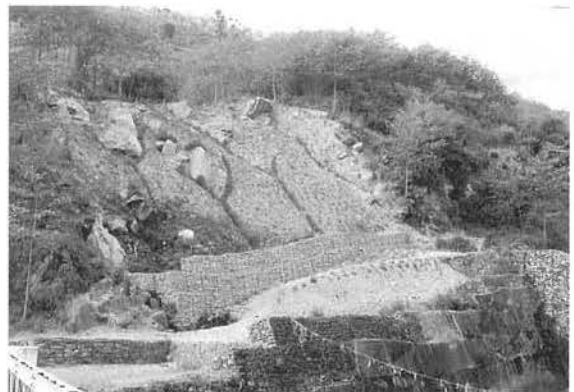
写真-5 山留ふとん籠擁壁と整形された法面に作られた暗渠工
