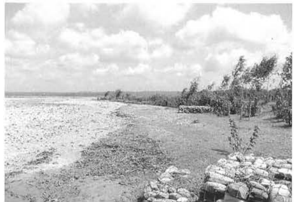
写真-4 植生工法による護岸工——水制工の間と堤防にはシッソ（背の高い木）とベサラム（匍匐性で流水の力に強い）が植えられている
