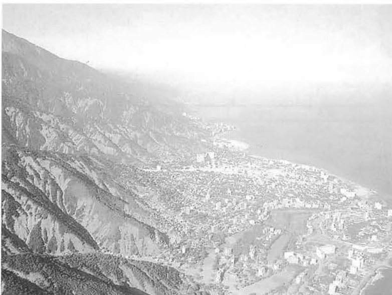
ロスコラレス地区の全景と背後斜面の崩壊状況
