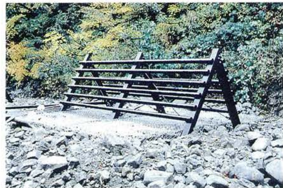
写真-1 スクリーン枠設置状況
