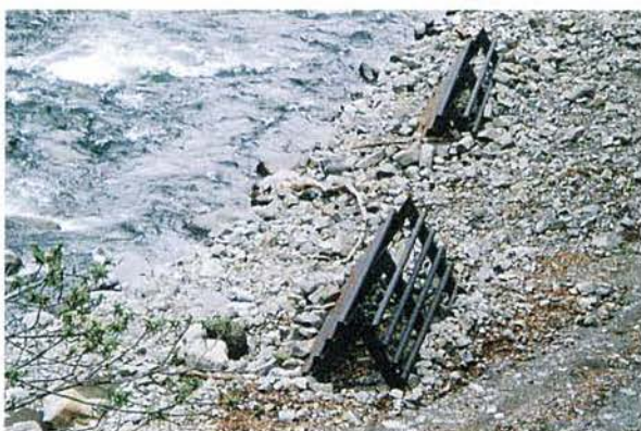
(a) スクリーン枠水制の後面の粒径は、スクリーン枠水制前面およびスクリーン枠水制間の粒径に比べて小さい。
