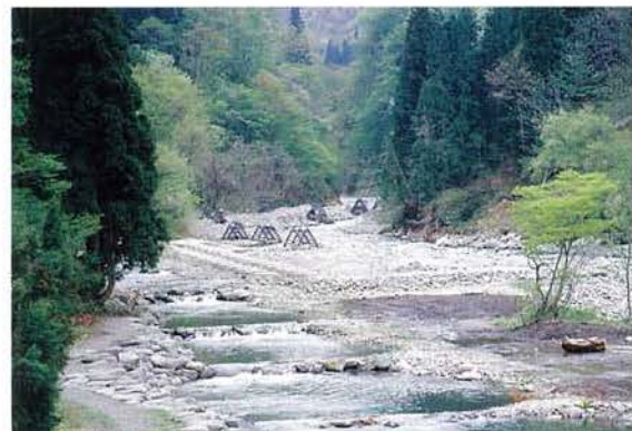
写真-4 遊砂地に設置されたスクリーン枠水制（下流側）と土砂調節工（上流側）。写真左側手前がフィッシングパーク。
