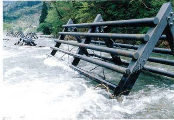
(b) 上流側スクリーン枠水制工周辺の流況 スクリーン枠水制の河道寄り、構造体の中、渓岸寄りの水面形の変化から、スクリーン枠に集中する流れが減勢されている状況がわかる。
