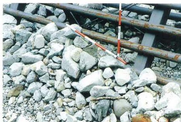
(b) スクリーン枠水制の前面に堆積した石礫の状況。
