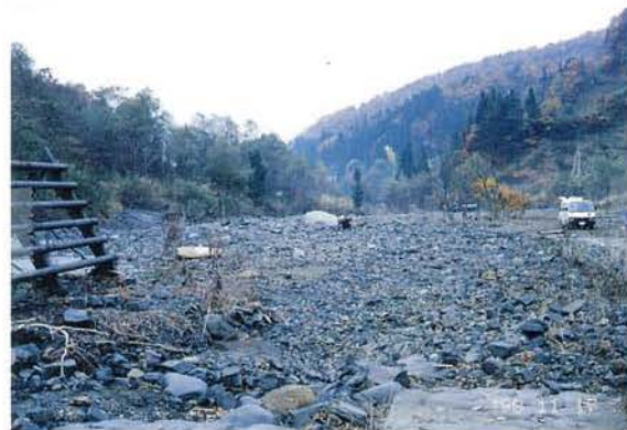
(c) 水制工下流付近の河床状況
