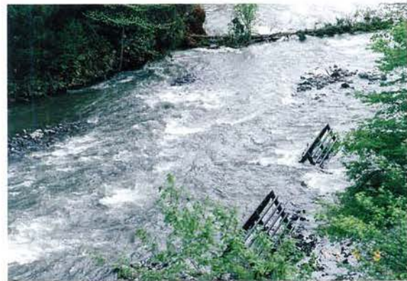
(c) 上流側スクリーン枠水制間の流況 スクリーン枠水制と下流のスクリーン枠水制との間の流勢と河道中央寄りの流勢を比較することにより、スクリーン枠水制の減勢効果ができる。また、スクリーン枠水制は主流を左岸渓岸側に寄せる水は効果を発揮している様子が見える。
