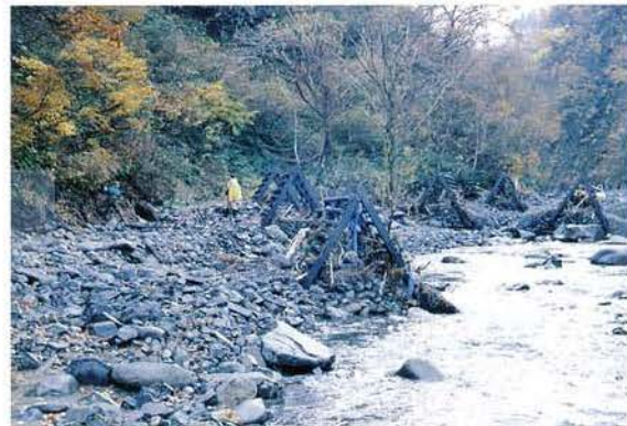
(b) 水制工中流付近の河床状況
