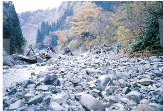
(a) 土砂調節工上流付近に堆積した土砂の状況
