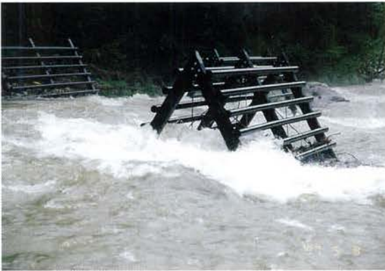
(a) 土砂調節工（スクリーン枠）による流れの減勢 スクリーン枠の頭部と後部の水面形の変化から流れは減勢されていることがわかる。
