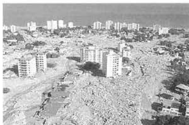
土石流により壊滅的被害を受けたロスコラス地区
