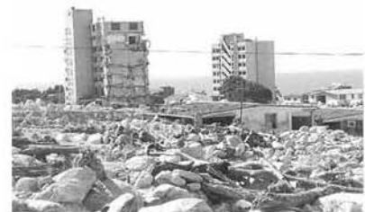
土石流の直撃を受けた低層住宅は破壊され埋め尽くされ、高層住宅も柱が飛ばされ、半壊状態のものもある
