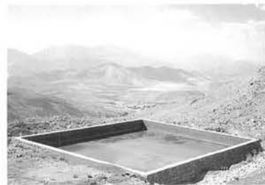
写真-7 プロジェクト地域上流にある灌漑のために大切な湧水を溜める貯水池
