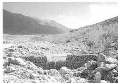
写真-6 空石積みのチェックダム (堆砂地に植樹されている)
