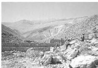
写真-16 被災農地の上流山地でジハード省が工事を行っている練石積の砂防ダム
