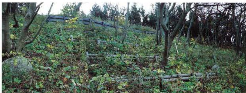
写真-11 調査例【青森県：上小屋野地区】 工法：土留柵工+編柵工
