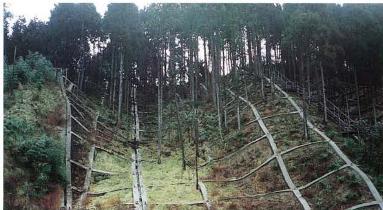
写真-8 調査例【秋田県：蒲田地区】 工法：大間隔法砕工
