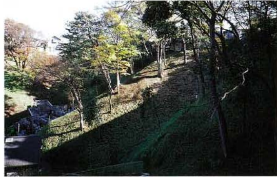
写真-13 調査例【神奈川県：獅子ヶ谷光明寺地区】 工法：鉄筋挿入工+連続繊維補強型
