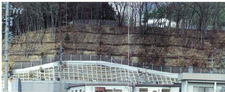
写真-9 調査例【長野県：下川手地区】 工法：鉄筋挿入工
