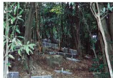
写真-10 調査例【長崎県：日野地区】 工法：鉄筋挿入工
