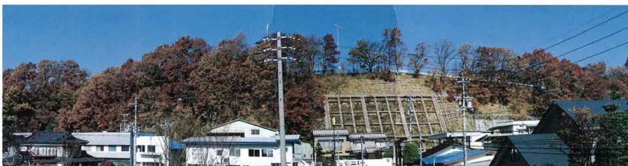
写真-1 従来工法による施工状況【長野県：下川手地区】
