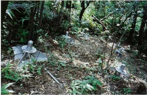
写真-12 調査例【山口県：遠ヶ崎東地区】 工法：鉄筋挿入工+ワイヤー連結型
