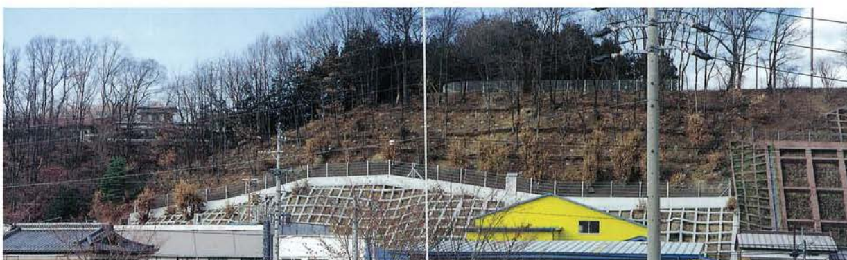
写真-2 緑の斜面工法を採用した施工状況【長野県：下川手地区】
