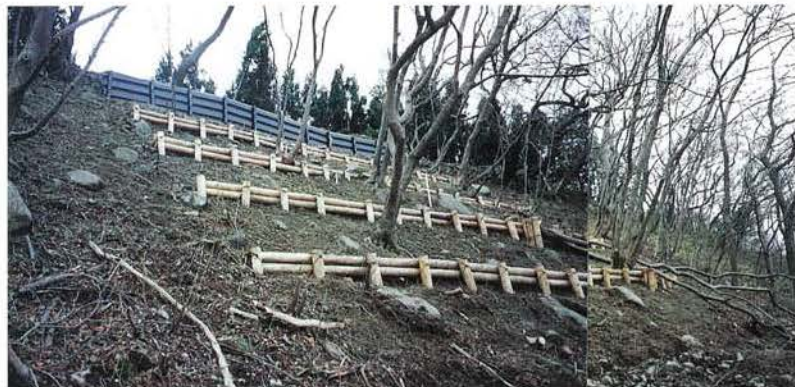
写真-14(1) 施工直後 1999年3月
