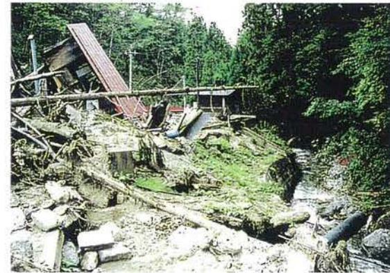
P-3 水洞谷正面より下流側では小谷本川まで土砂は達していない。 倒壊している建物は、養魚場管理小屋とみられる。
