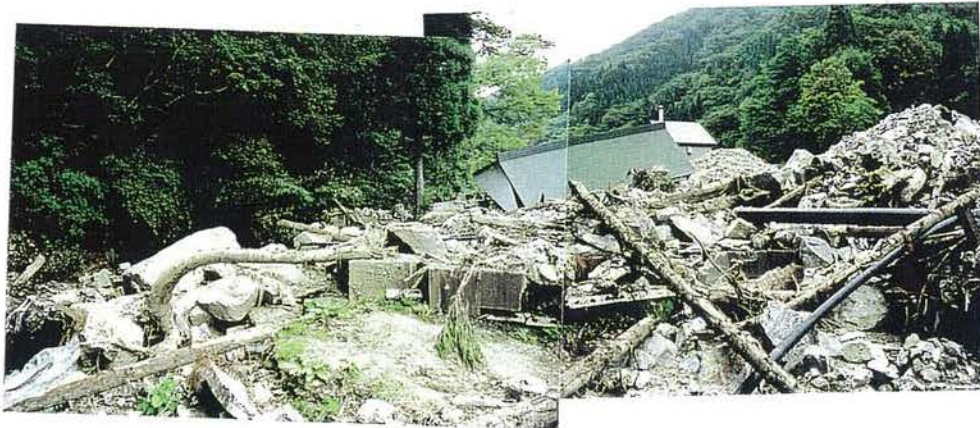
P-2 水洞谷の正面では、既存の建物を破壊した礫および流木が小谷川本川に達している。傾いている建物が小谷公民館とみられる。
