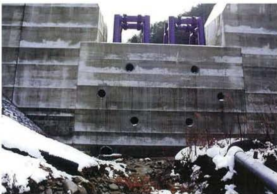
ダム上流（堆砂域）から見た本堤の様子
