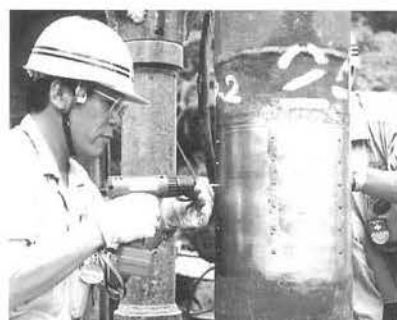
写真-3 ボルトの締め込み
