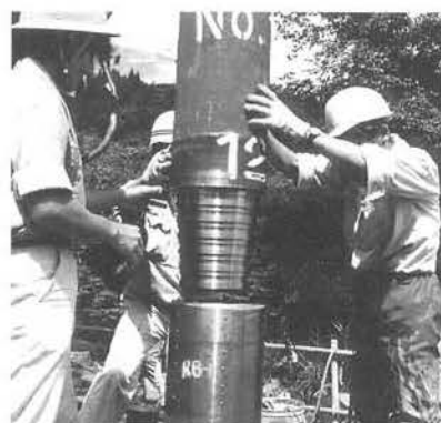
写真-2 継手の挿入
