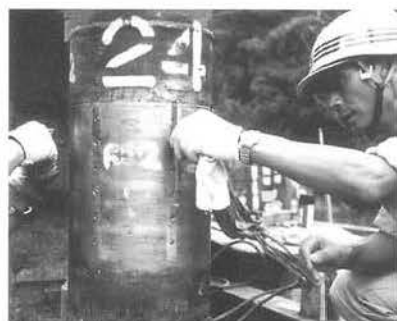
写真-4 接合完了の確認
