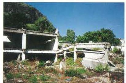
写真-3 地すべり末端部における建物の全壊状況
