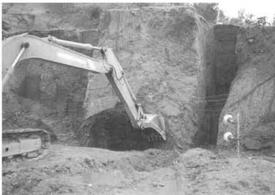
写真-1 整形された斜面
