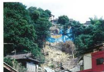
的場5丁目 崩壊による被害状況 崩壊土砂は斜面直下の家屋を直撃した。
