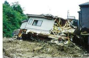
伴東1丁目 土石流による被害状況 土石流が家屋を直撃した。家屋の1階部分は全壊し、2階部分は下流に押し流された。
