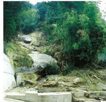
吉浦東町 下流部の状況 溪床に比較的新鮮な花崗岩の露頭が見られる。この露頭の直下流に被災者宅があり、土石流により家屋は破壊され、道路をはさんで向かい側の家屋も全壊した。
