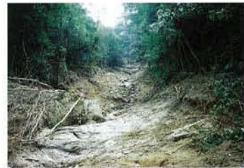
吉浦東町 土石流流下域の状況 溪床は露岩している。両岸には崩積土が堆積している。
