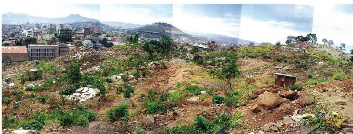
写真-5 地すべり下部 避難していた住民が早くも簡易な小屋に住み始めた。
