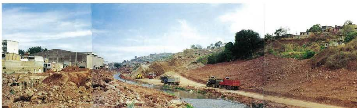
写真-6 地すべり末端、 Cholteca川の開削工事
