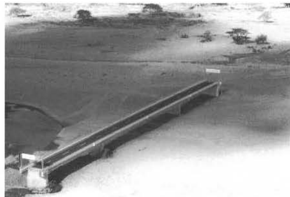
Choluteca川の下流に架かる新Choluteca橋。この橋は日本政府の無償資金協力援助で建設され、橋梁自体に被害はなかったものの、ホンデュラス政府建設の橋梁前後のアプローチ部が流失した。
