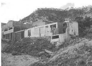
首都テグシガルパ市内で発生したソト地区地すべり。写真は土砂が末端を流れる Choltecalca川の、対岸の建物まで土砂が流れ込んだ状況。
