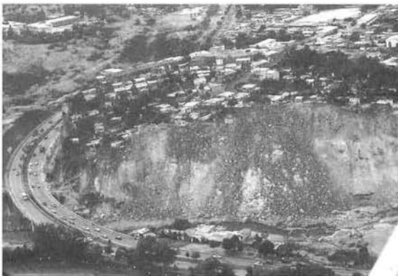
首都テグシガルパ市内で発生したヌエバ・エスベランサ崩壊。がけ上にあった住宅が巻き込まれ、現在も犠牲者ががけ下に埋まっている。このような状態でもがけ上の住民は、危険は承知でも低所得ゆえ移転する場所がないために住み続けている。
