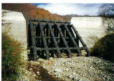
下流からみたダム正面
