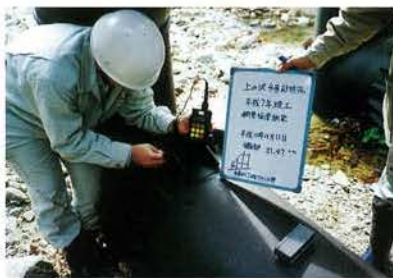
板厚測定フランジ健全部
