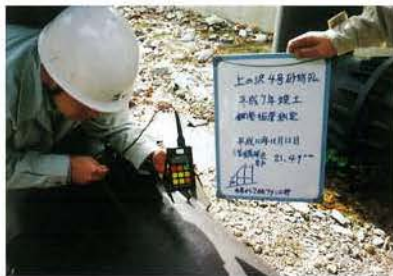
板厚測定フランジ浮き錆除去部
