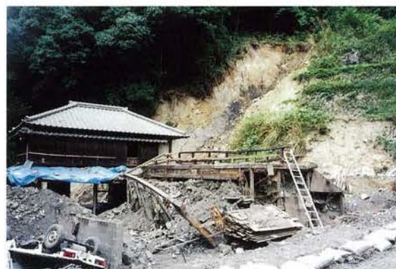
平山における被害状況 支川の流水も係わり約200m下流の人家を埋没。
