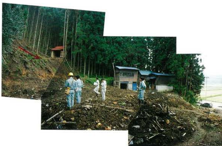
羽太(はぶと)がけ崩れの人家被災状況 斜面勾配35°の風化層が崩れ、斜面直下の人家を直撃した(人家1戸全壊)。 人家の斜面上方に位置していた神社の社はかろうじて被災をまぬがれた。
