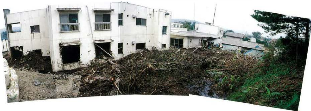
太陽の国(からまつ荘)への土砂流入状況 背後の渓流内で発生した3箇所の崩壊土砂は渓流出口に位置する建物に流入した。礫は少なく火山灰質土からなる泥と流木が、施設内の災害弱者を襲い就寝中の5名の命を奪った。
