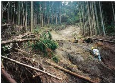
羽太 (はぶと) がけ崩れ 風化層崩壊タイプで、溶結凝灰岩の風化部が崩壊した。崩壊源頭部の横断形は凹状を示し、地表水が集まりやすい集水地形をなす。斜面の勾配は35°と急傾斜を示し、杉の植林として利用されている。
