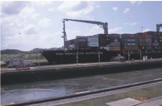
写真-1 ペドロミグエルの閘門を通過中のコンテナ船
