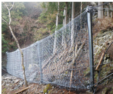
施工事例 奈良県 (RXE-3000、3000kJ対応型)
