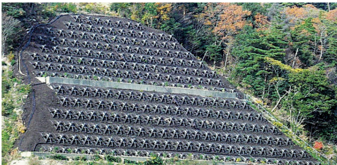
法面工事での施工事例
