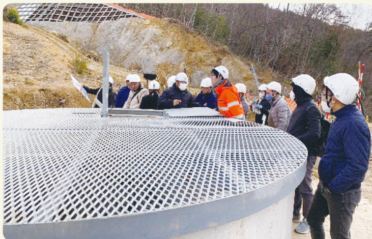
小松原地すべり対策工事現場(12月7日)
