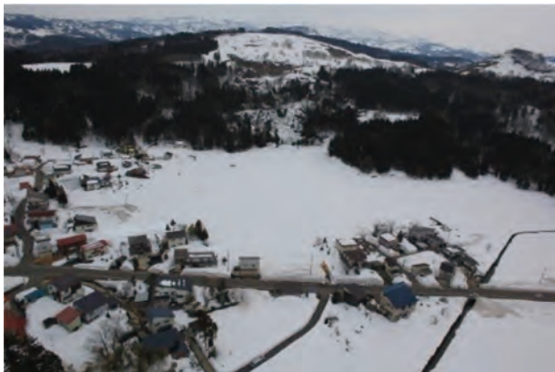
写真-6.2.1 地すべり発生状況①（平成24年3月8日時点）
