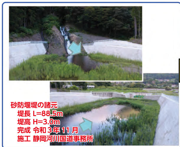
図-4.2 ピワミズ沢沈砂地工による土砂捕捉状況（写真提供：静岡県）
