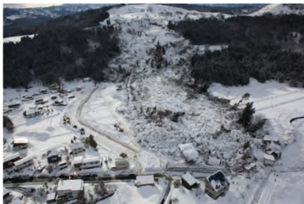
写真-6.2.2 地すべり発生状況②（平成24年3月13日時点）
