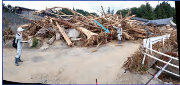
写真-5.1.3 集落内に堆積した流木の下流端（橋梁）の状況
