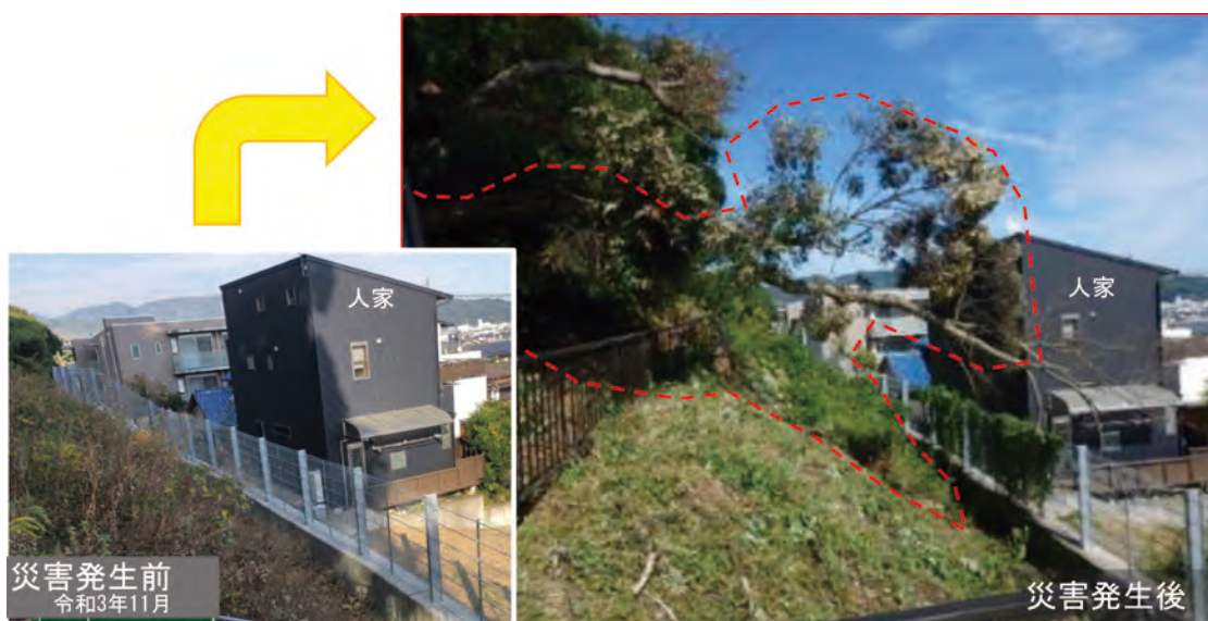
図-4.3 急傾斜地崩壊防止施設による土砂捕捉状況（写真提供：静岡県）
