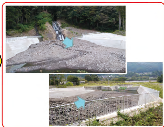
図-4.2 ピワミズ沢沈砂地工による土砂捕捉状況（写真提供：静岡県）
