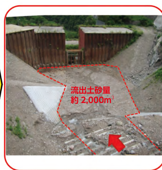
図-4.1 祖山出谷砂防堰堤による土砂・流木捕捉状況（写真提供：富山県）
