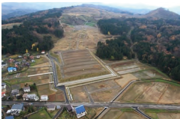
写真-6.2.3 地すべり対策工完了（平成25年12月3日撮影）
