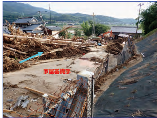
写真-5.1.6 泥水等によって流失した家屋の被害状況
