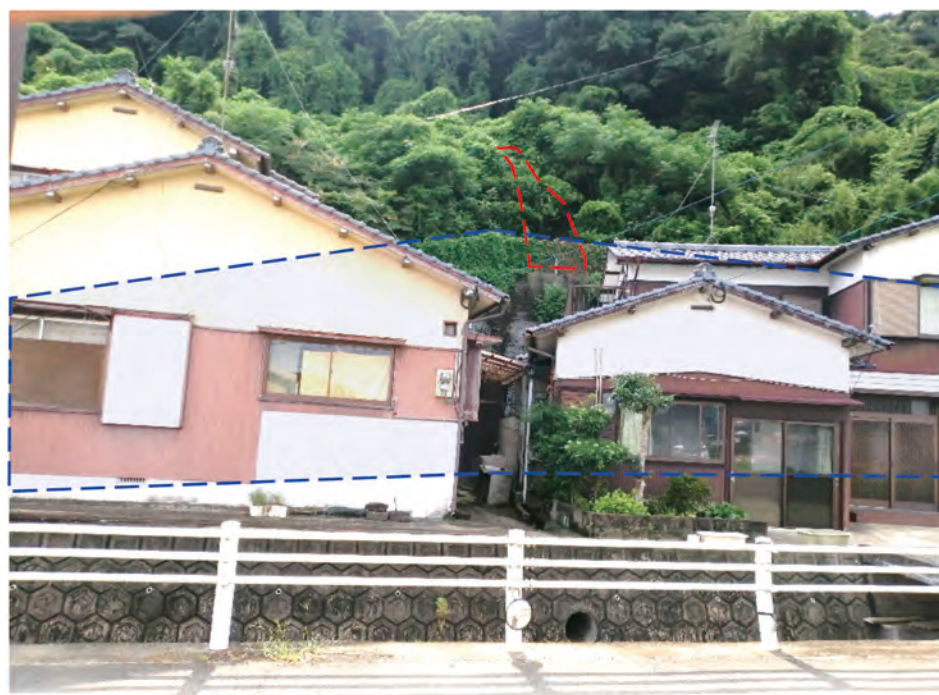
図-4.4 急傾斜地崩壊防止施設による土砂捕捉状況（写真提供：佐賀県）
