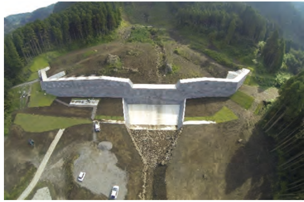
写真-6.1.2 砂防堰堤完成状況（平成26年7月） （災害関連緊急砂防等事業）
