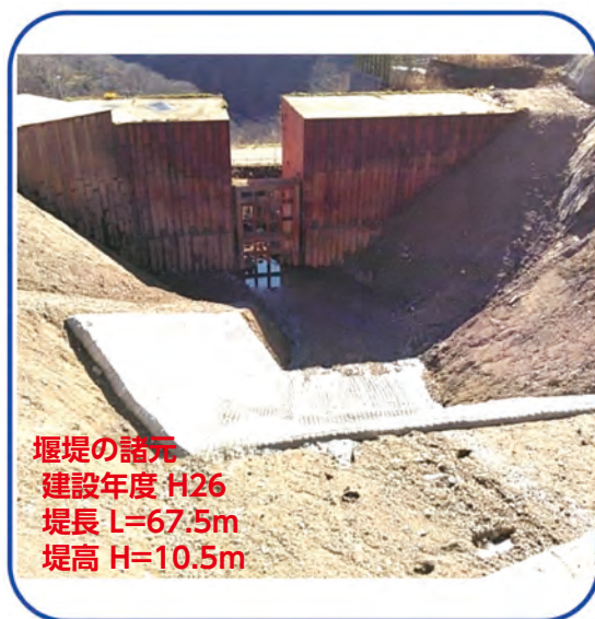
図-4.1 祖山出谷砂防堰堤による土砂・流木捕捉状況（写真提供：富山県）
