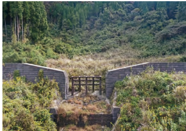
写真-6.1.3 砂防堰堤完成状況（平成28年3月） （砂防激基災害対策特別緊急事業）
