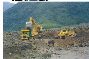
除石工・掘削工
