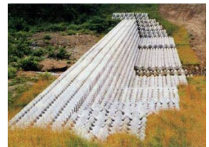
コンクリートブロックえん堤
