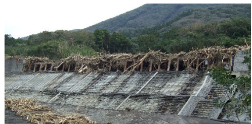
（大金沢本川堆積工；東京都伊豆大島）
