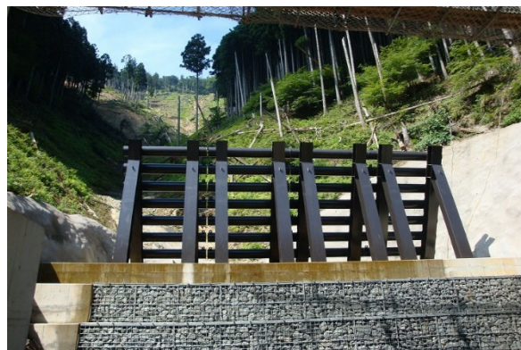
(兵庫県養父土木事務所管内) 小規模溪流などの下流に流路が準備できないゼロ次谷等に 適した鋼製土石流・流木捕捉工
