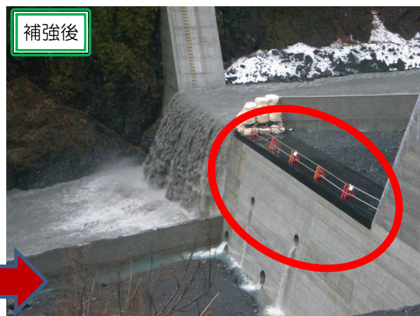
ラバーSteelによる磨耗対策を加えた砂防堰堤改築事例 稲又砂防堰堤 (富士川砂防事務所管内；山梨県南巨摩郡早川町)
