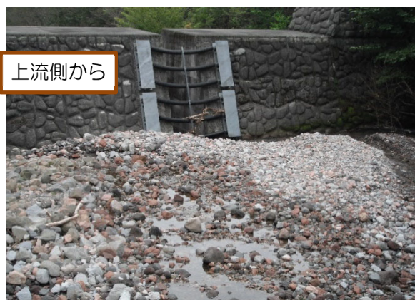
スリットバーによる砂防堰堤の捕捉機能向上を実施した事例 鳥居川上流一号砂防堰堤 (渡良瀬川河川事務所管内；栃木県桐生市黒保根町)
