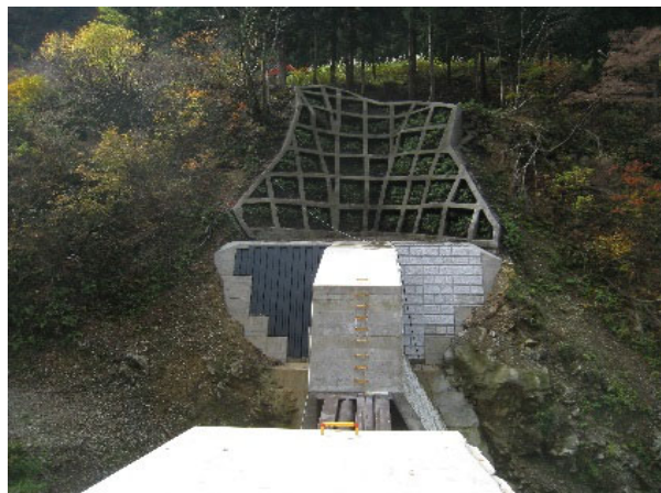
マス沢第2号砂防堰堤 (湯沢砂防事務所管内；新潟県南魚沼市) ※砂防ソイルセメント施工便覧(平成28年版)より抜粋
