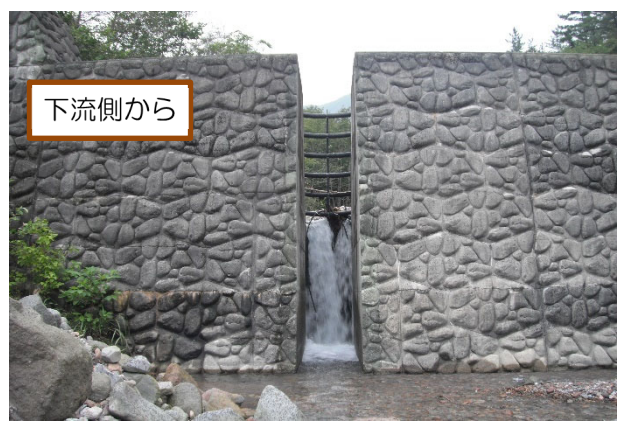
スリットバーによる砂防堰堤の捕捉機能向上を実施した事例 鳥居川上流一号砂防堰堤 (渡良瀬川河川事務所管内；栃木県桐生市黒保根町)
