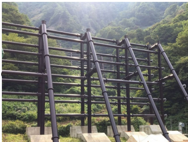
雪崩減勢工 （石川県石川土木総合事務所管内；石川県白山市中宮）
