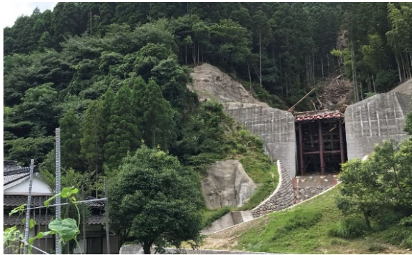
砂防堰堤（Jスリット） 柚ノ木川砂防堰堤（捕捉直後の写真） 谷出口に設置された本堰堤は、H29九州北部豪雨による 土石流・流木を捕捉し、直下流の人家を保全した。 （大分県日田土木事務所管内；大分県日田市鶴河内）
