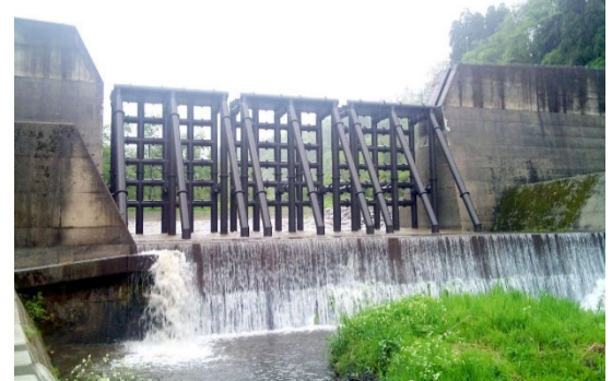
雪崩減勢工 （石川県石川土木総合事務所管内；石川県白山市中宮）
