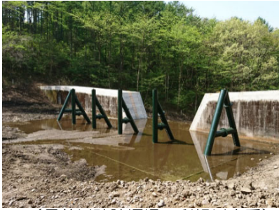
(長井川砂防堰堤；利根川水系) (満砂型)
