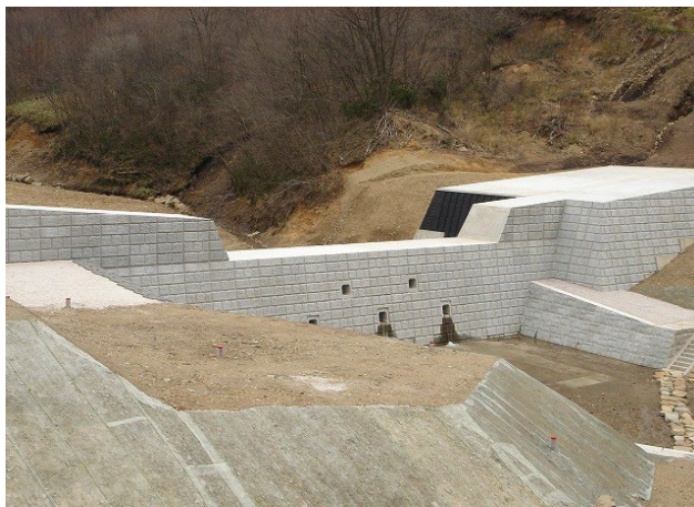
篠堂川8号砂防堰堤 (広島県北部建設事務所管内; 広島県庄原市) ※砂防ソイルセメント施工便覧(平成28年版)より抜粋
