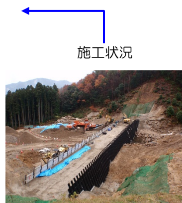
宮内2号砂防堰堤 (太田川河川事務所管内 ; 広島県廿日市市宮内)
