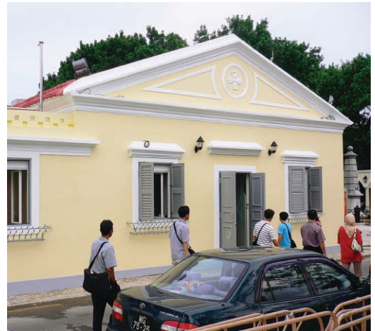
建設中の台風委員会の事務所
