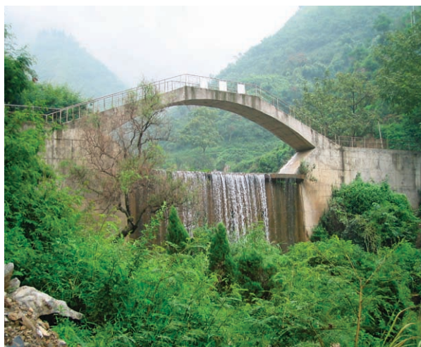
写真-6 深溝の堰堤と歩道橋
