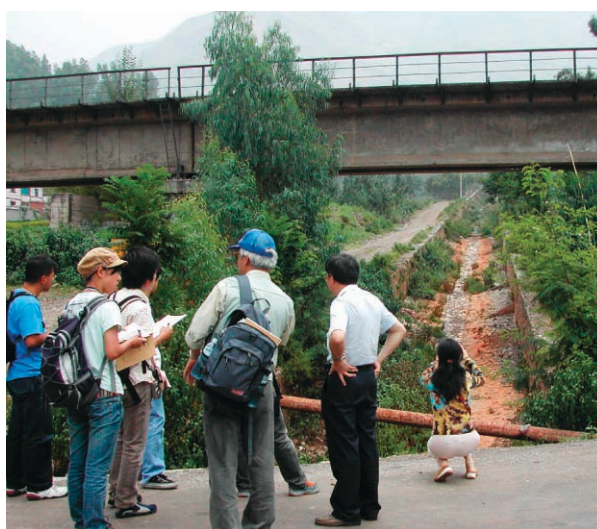
写真-5 黒水溝の流路工と鉄道の高架橋
