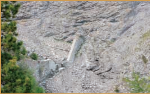
写真-5 修復された砂防えん堤（サニエル溪）
