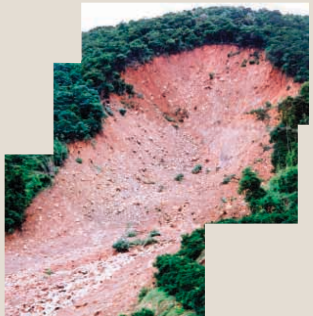
写真-1 針原深層崩壊地
