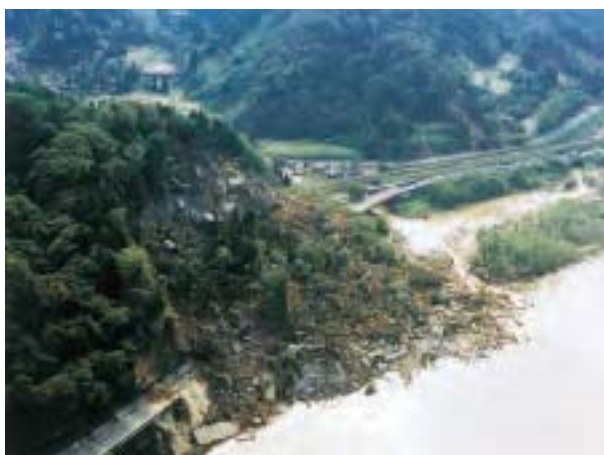
写真2-1 小千谷市浦柄地内（県道被災）
