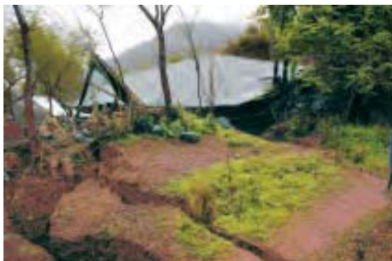
写真3 ドパッタにおける撓曲崖上のクラックの発達と家屋の倒壊
