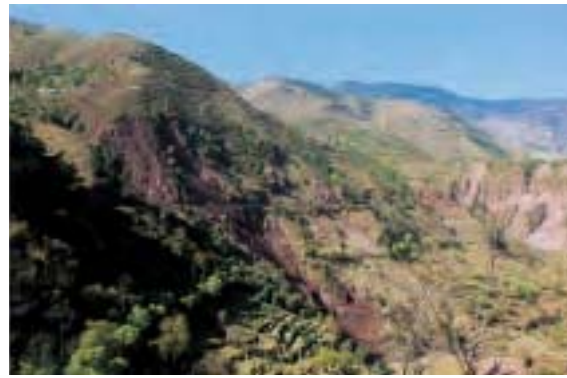
写真5 ダニー東の攻撃斜面上部の深層地すべり
