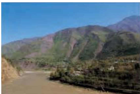
写真2 バンディ・タギアンにおける地震断層沿いの斜面崩壊
