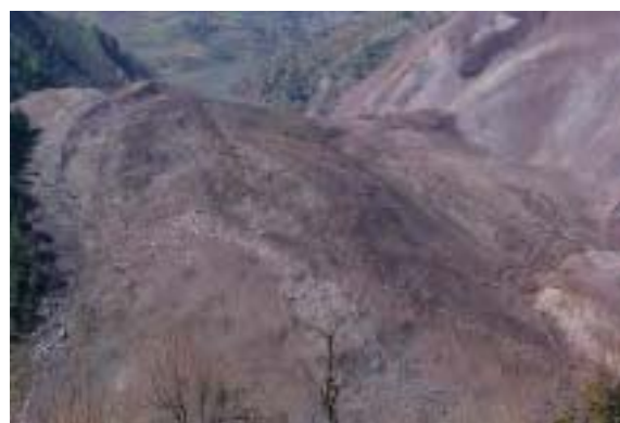
写真9 地すべりダムをなす地すべり移動土塊
