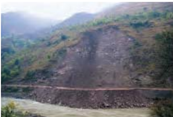
写真6 バディハラにおける岩盤地すべり
