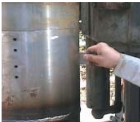
写真2 接合完了の確認
