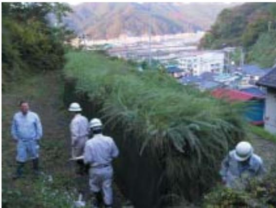
写真3 がけ地近接等危険住宅移転事業で移転し、その住居跡地に土堤を設置した事例（釜石市嬉石地区：背後は釜石港）
