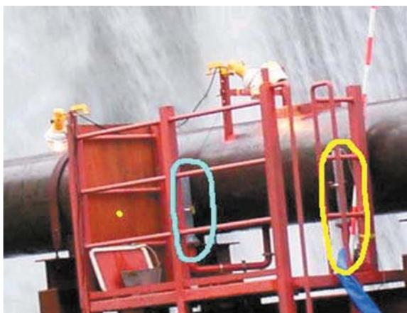
写真1 導水管に設置した圧力式水位計（水色丸）と濁度計（黄色丸）
