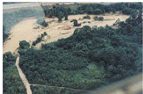
写真2 災害発生時の写真：HP情報写真 図4中の⑤
