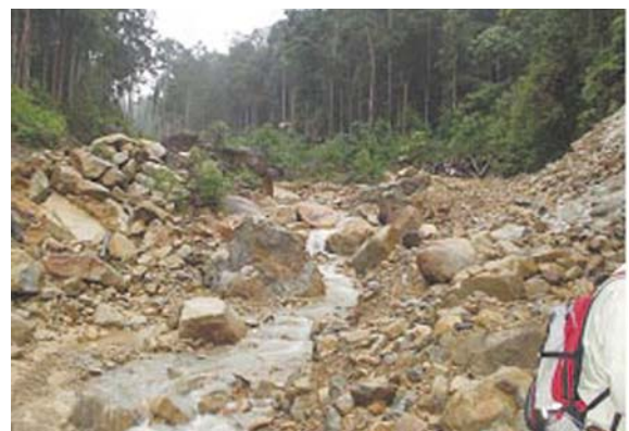
写真5 土石流発生場所の状況（2003年12月の現況写真）
