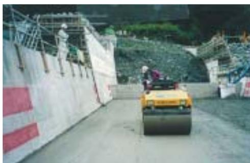
写真-1 INSEM工法による転圧作業状況
