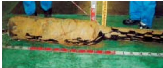
写真3-1 SSL P型アンカー体造成掘り起こし確認状況
