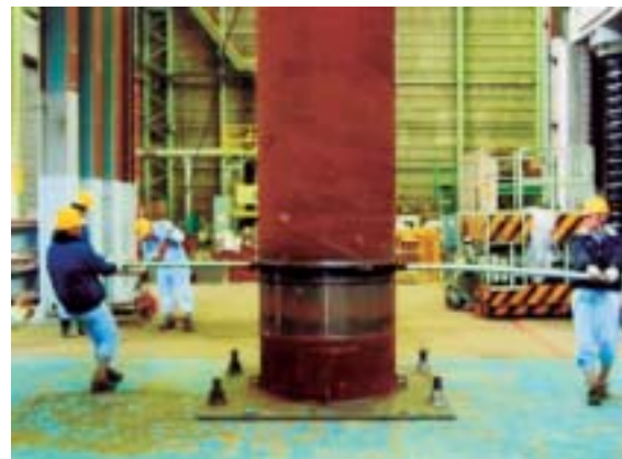
写真1-4 大口径継手付鋼管杭のねじ込み （鋼管径 1,200mm）
