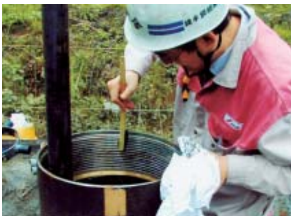
写真1-1 ねじ部の清掃・潤滑油の塗布
