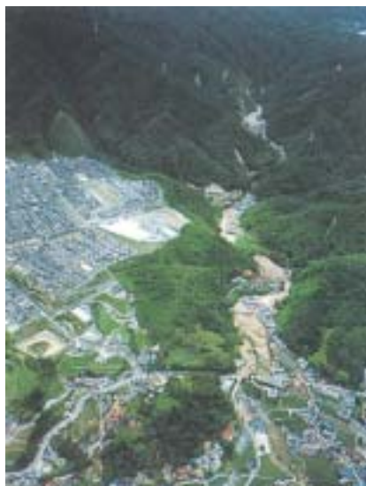
広島土石流災害（平成11年） 出典「土砂災害の実態」平成11年版
